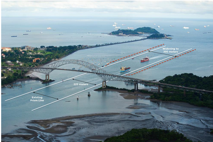
Photo : Élargissement et approfondissement de l'accès au canal de Panama
