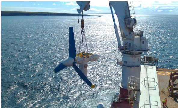
Photo 2 | Installation d'une turbine pour énergie marémotrice
